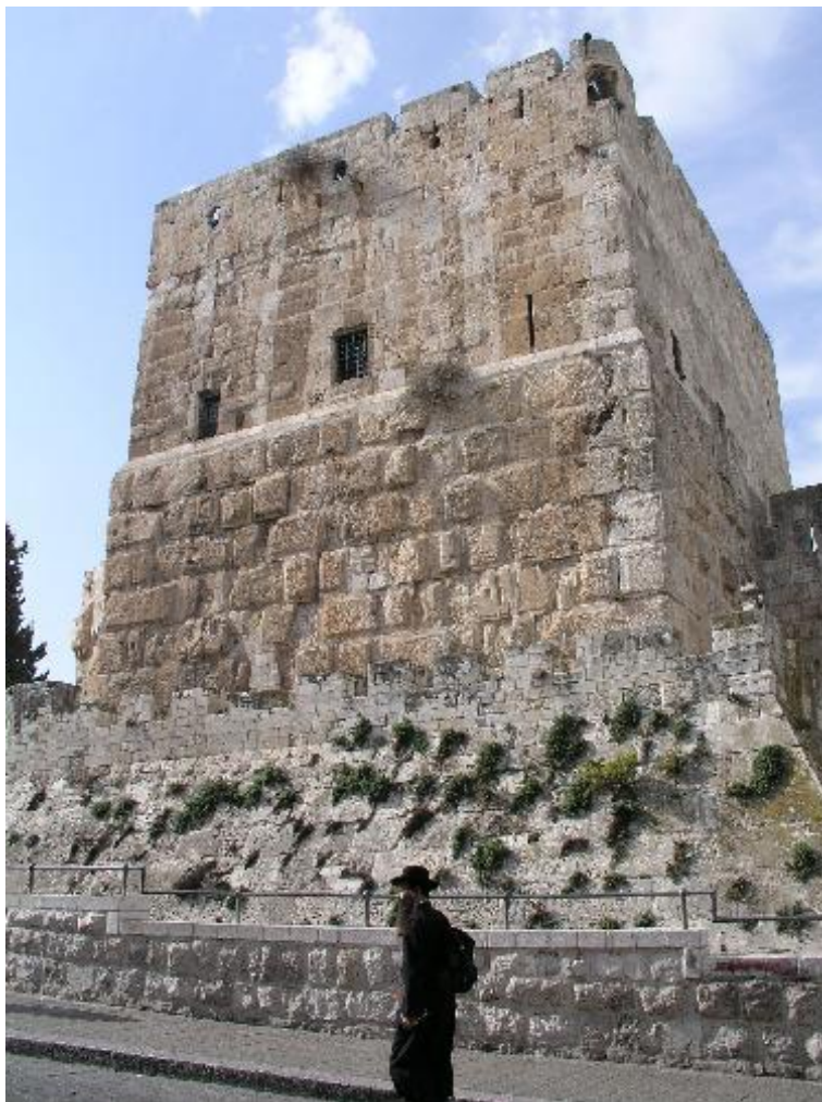
Torre di Davide
